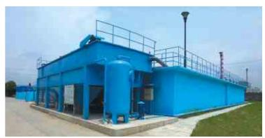
● 优化溶气压力和回流比能够有效地降低水厂的运 行和维护费用。此外由于停留时间短,气浮池的基建费用比沉淀池少,但却能获得更好的处理效果。 外形紧凑,占地小。设计合理,电耗省。溶气效率高,操作方便,维护简单。处理效果稳定,机电仪实现了一体控制。.按不同 的水质及工艺要求:可提供单溶气装置或双溶气装置;可提供溶气水压力调整系统。
